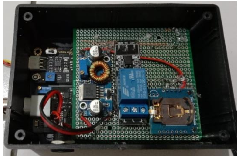
Gambar 4. Pemasangan sejumlah komponen pada sistem pemantauan kualitas air limbah
