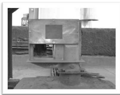
Gambar 17 Hasil pemasangan silopilot FMM 760
