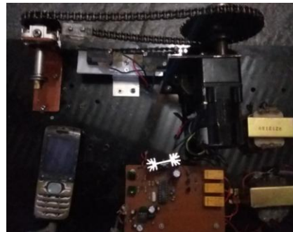
Gambar 17 Hasil pemasangan sistem penggerak
