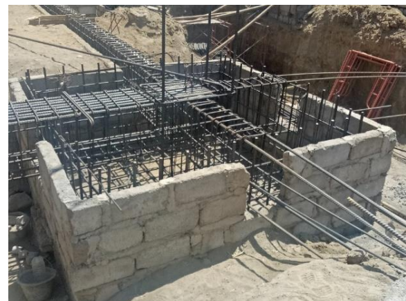
Gambar 6. Pekerjaan Tulangan Pile Cap
