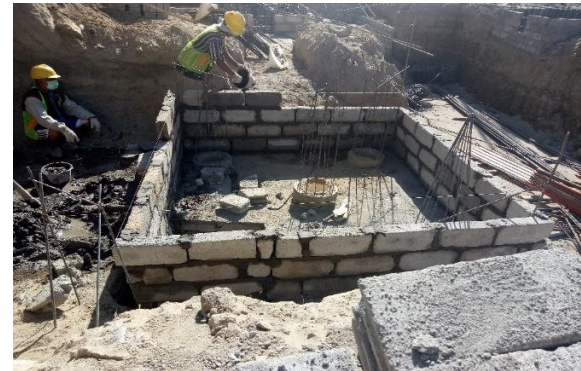
Gambar 5. Pekerjaan Pasangan Batako
