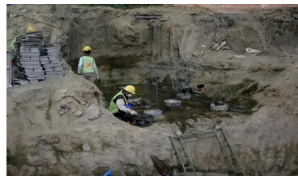
Gambar 4. Pekerjaan Lantai Kerja
