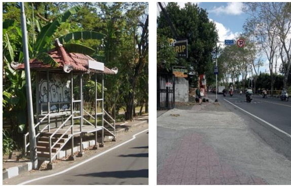
Gambar 3. Salah satu kondisi Halte Trans Metro Dewata
